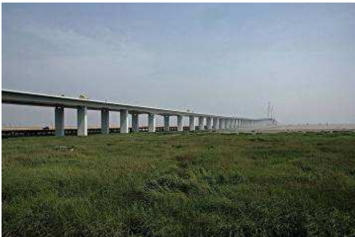
Hángzhōu Wān dàqiáo 杭州湾大桥 , Hangzhou Bay , 36km , 2008
