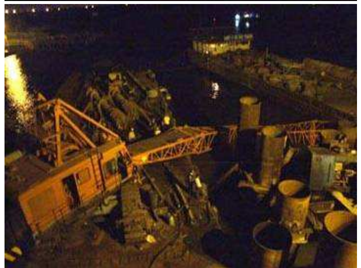
Trục cầu đổ sập nằm vắt ngang hai sà lan
