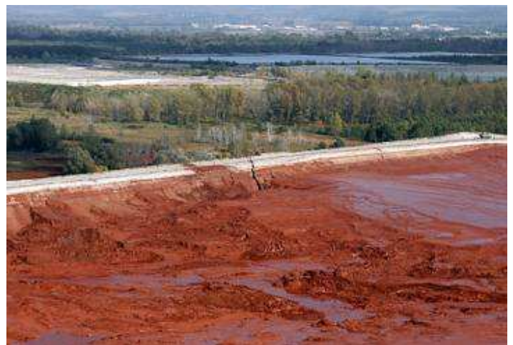
Vendredi 8-10-2010, de nouvelles fentes sont apparues sur le mur du réservoir près d'Ajka.
