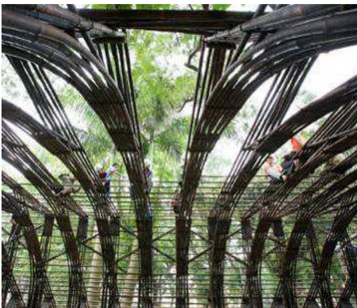
Những người thợ đang thi công phần khung mái.
