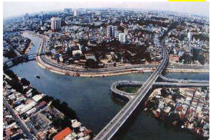
Cầu Nguyễn Văn Cừ Và Cầu Chữ Y
