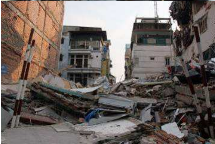
Những chiếc cột bê tông mảnh mai gãy gập, để lộ ra hai sợi thép nhỏ. Nhiều người dân dự đoán, đây chính là nguyên nhân khiến tòa nhà 5 tầng đổ sụp.
