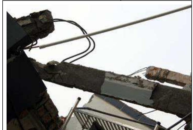
Những chiếc cột bê tông mảnh mai gãy gập, để lộ ra hai sợi thép nhỏ. Nhiều người dân dự đoán, đây chính là nguyên nhân khiến tòa nhà 5 tầng đổ sụp.
